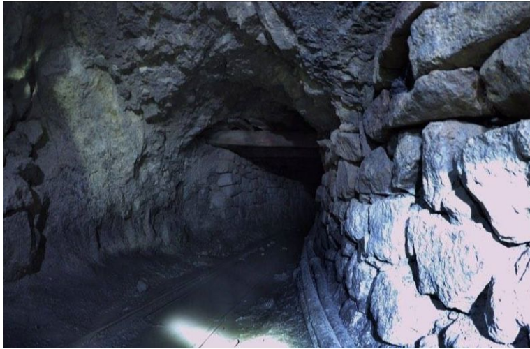
Foto: gedeelte van de tunnel
